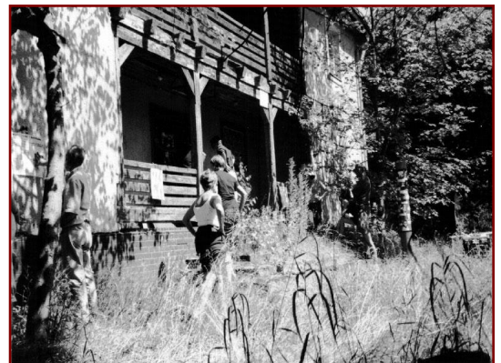
SS-Aufseherinnensiedlung vor der Sanierung
